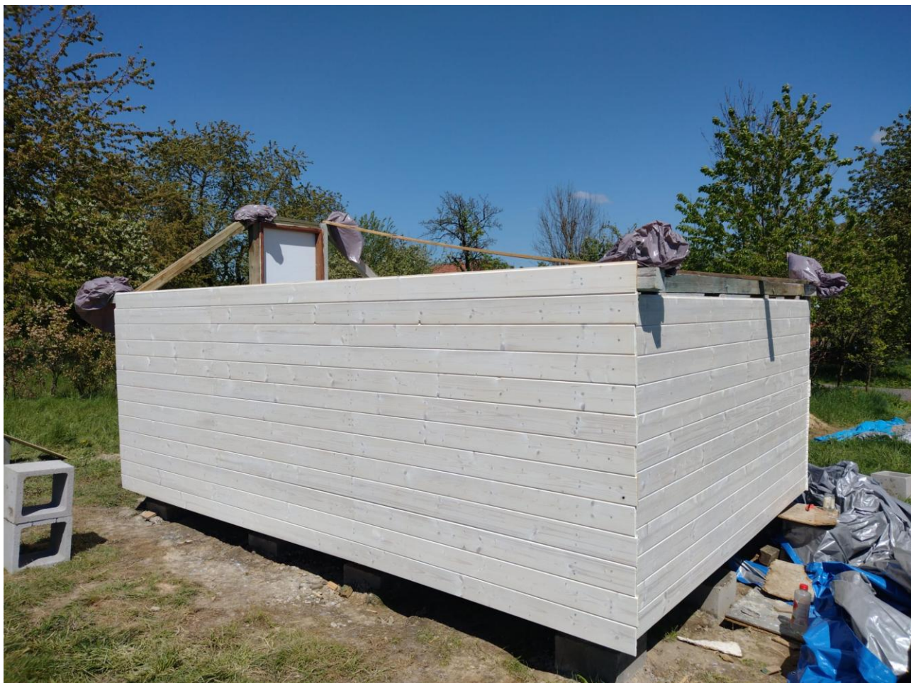
Hrubá stavba na konci léta 2024
